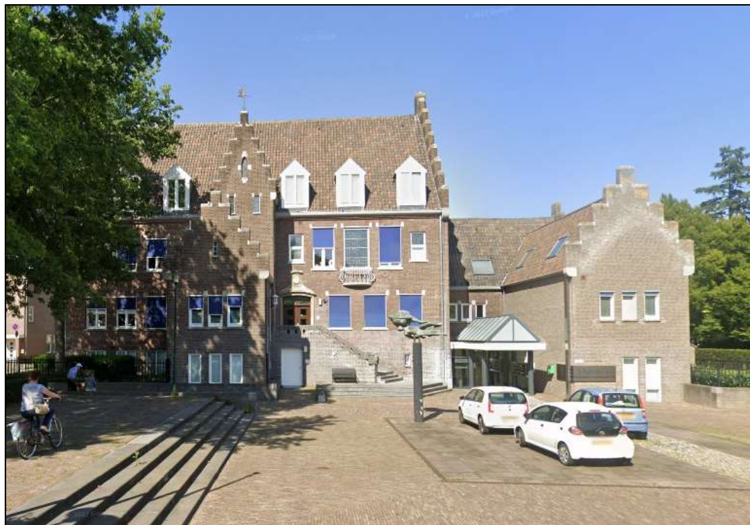
Aanzicht zuidgevel (bron: Google Streetview)
