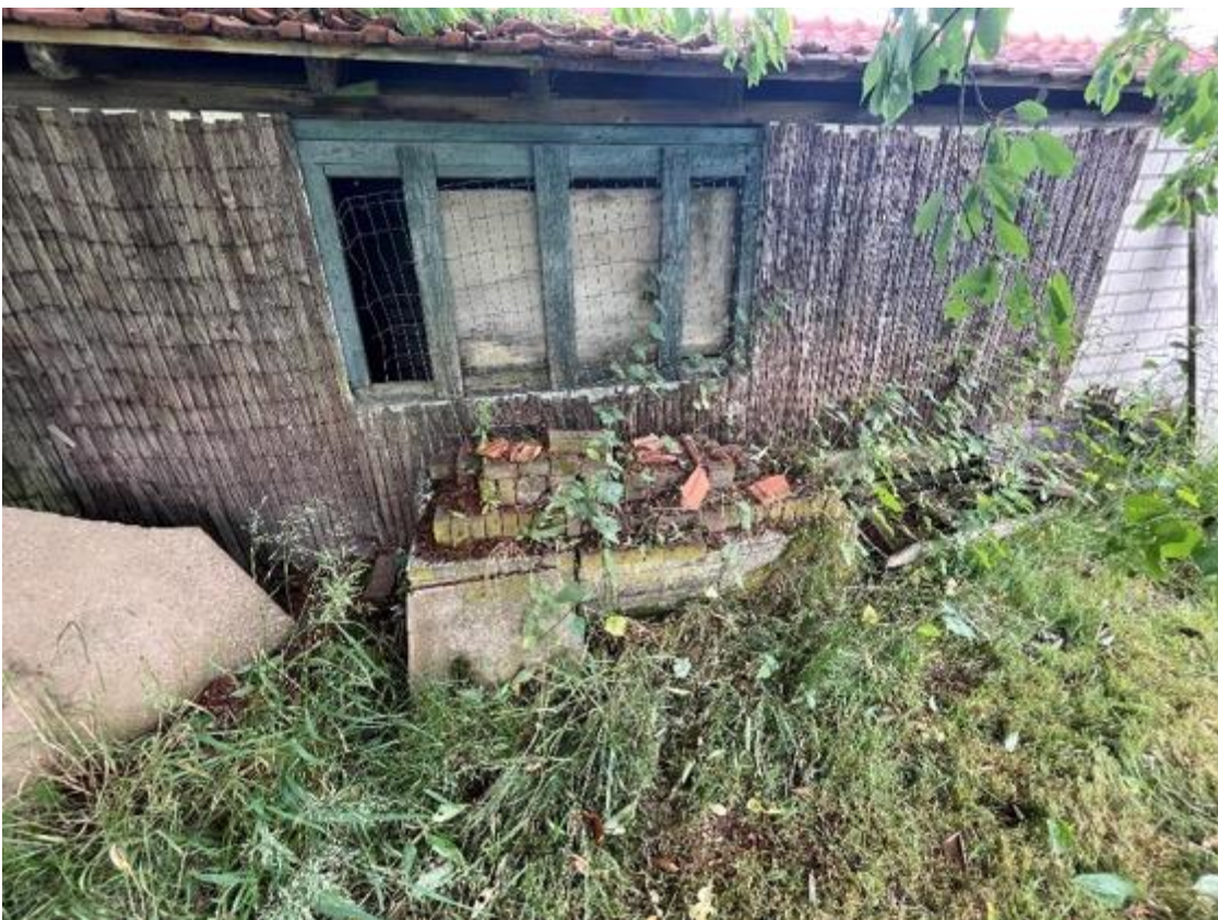
Afbeelding 4.5. Aanwezige losse elementen rondom de stal. Foto: I. Gorissen.
