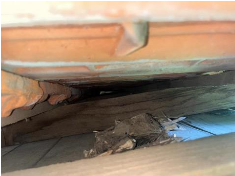
Afbeelding 6.3. Ruimte tussen betimmering en dakpannen. Foto: I. Gorissen.
