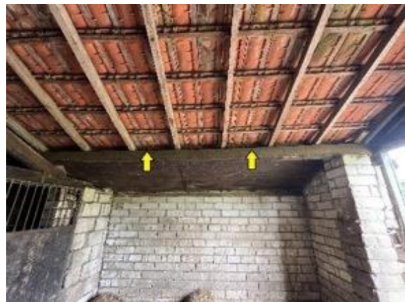
Afbeelding 6.7. Ruimte onder dakpannen geschikt als verblijfplaats. Foto: I. Gorissen
