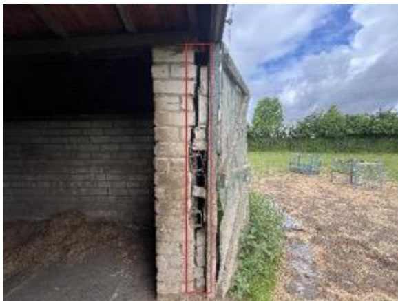
Afbeelding 6.6. Ruimte tussen muur geschikt als verblijfplaats. Foto: I. Gorissen
